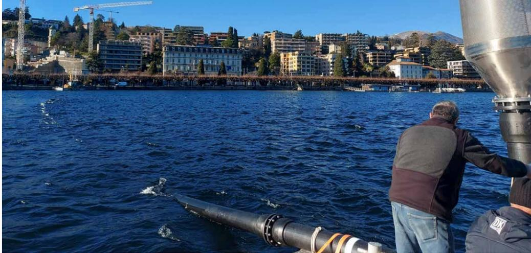
Una volta terminata la fase di trivellazione, sono state trainate dal lago fino all'interno del mappale in oggetto le due tubazioni in PEHD (con tecnica denominata "spingitubo"). La principale criticità di questa fase è stata controllare il possibile afflusso di acqua proveniente dal lago verso l'area di scavo di cantiere e garantire la sicurezza del cantiere.
